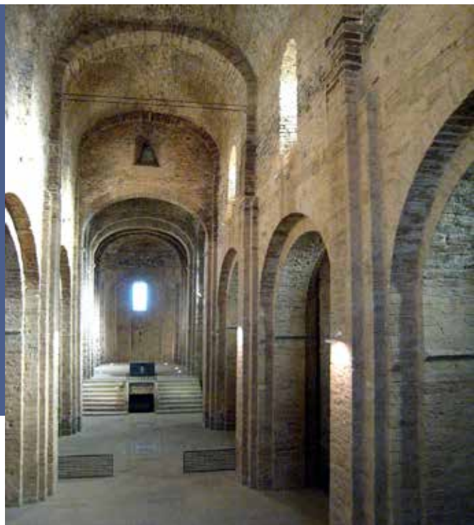
Sant Viçens de Cardona, vue intérieure
